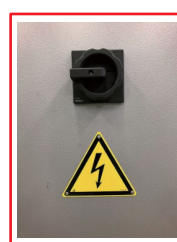
主電源スイッチ
